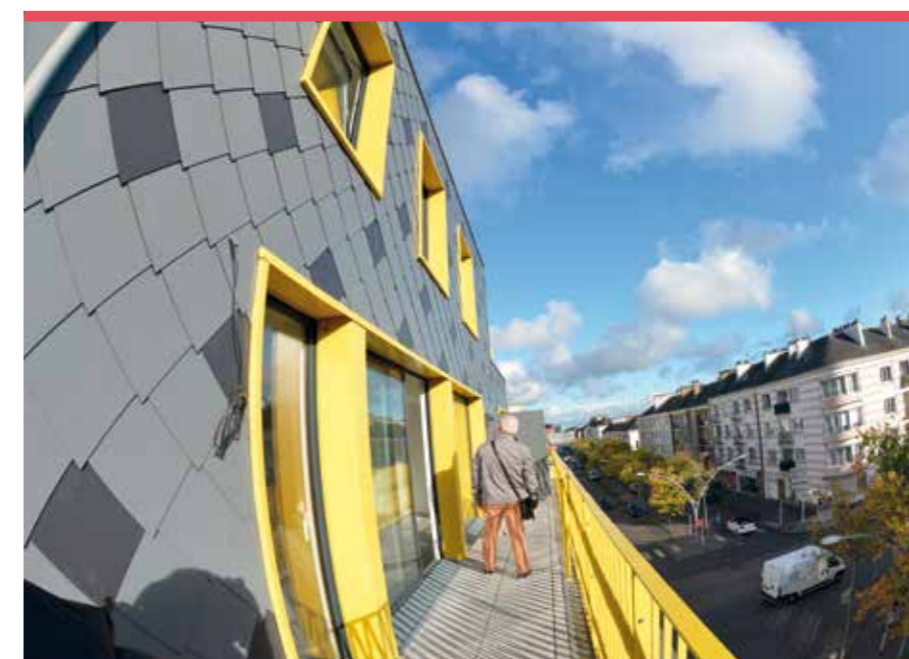
Le parti pris audacieux de l'architecte s'est traduit par la création de logements atypiques, aménagés en duplex et bénéficiant tous d'un espace extérieur.
